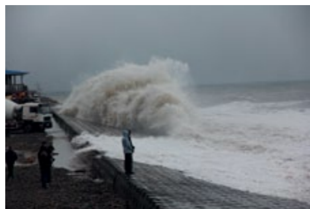
Рис. 5. «Жесткое» взаимодействие волн с сооружением и переливы через него
