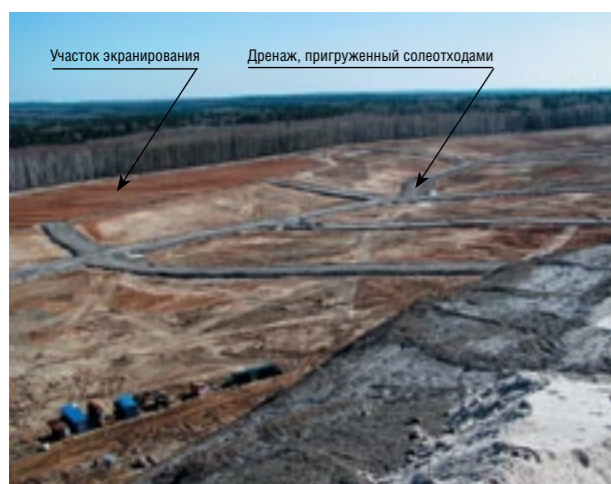
Рис. 2. Дренажная система и искусственный экран на участке расположения гидрогеологического окна в основании солеотвала
