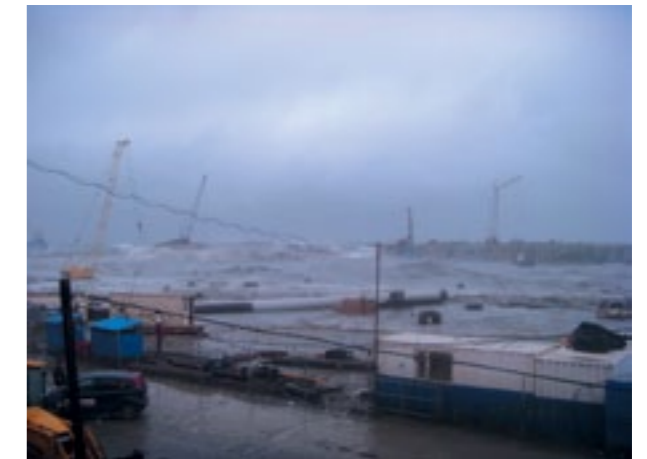
Рис. 5. Гребень волны, входящей в проран в оградительном сооружении, с роллером обрушения на отметке порядка +7,50 м
