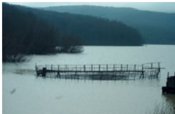
Рис. 10. Оголовок шахтного водосброса Неберджаевского водохранилища
