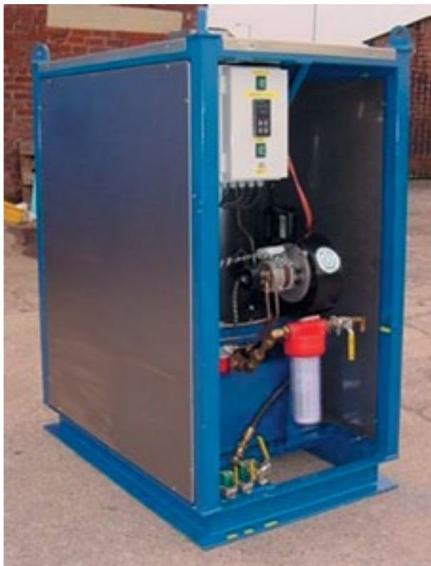
Рис. 3. Установка водообогрева SMP OF2000м
