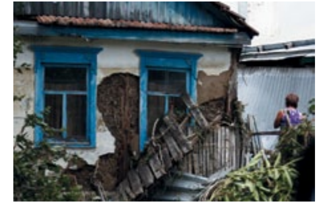
Рис. 4. Жилой дом в г. Крымске после паводка (видны отметки уровня воды на 7 июля 2012 г.)
