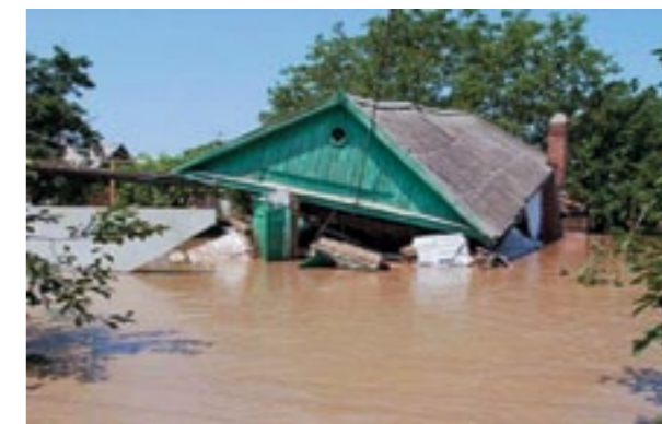
Рис. 4. Разрушение жилых построек в п. Новомихайловском [10]
