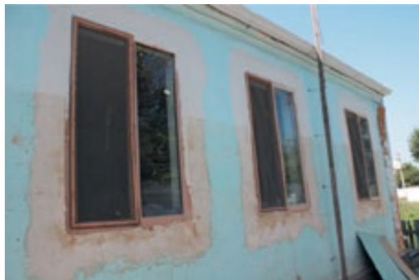
Рис. 7. Жилой дом в г. Крымске после паводка (видны отметки уровня воды)
