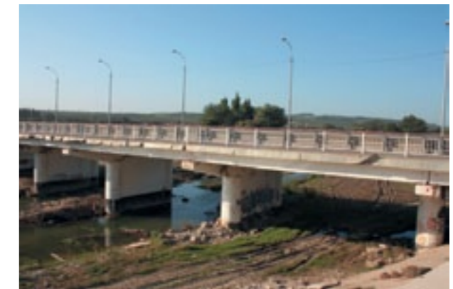
Рис. 6. Состояние автодорожного моста в г. Крымске после июльского паводка
