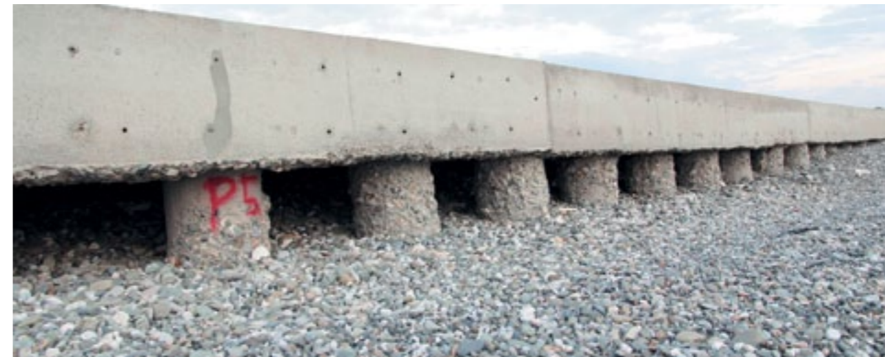
Рис. 6. Вид ростверка на сваях после шторма в районе оградительного мола порта
