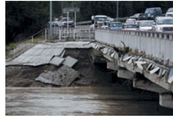
Рис. 3. Состояние автодорожного моста в г. Крымске после июльского паводка
