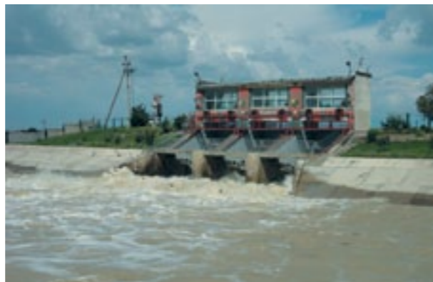
Рис. 9. Трехпролетный шлюз-регулятор водосбросного сооружения Варнавинского водохранилища
