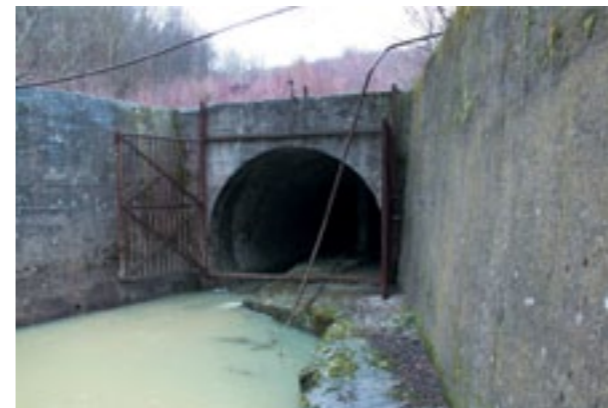
Рис. 11. Нижний бьеф шахтного водосброса Неберджаевского водохранилища
