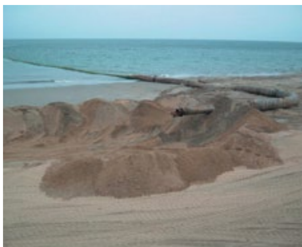
Рис. 5. Подпитка пляжа песком из морского месторождения
