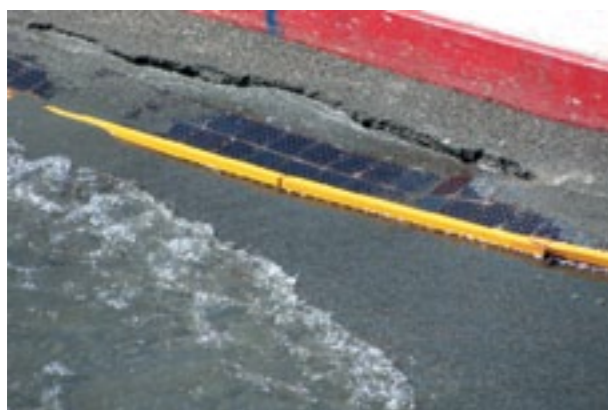
Рис. 4. Оголение свай и осадка блоков пронизаемого откоса у каньона Константиновский
