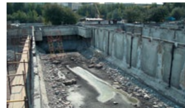
Рис. 1. Подольский водоканал — ремонт бетона
