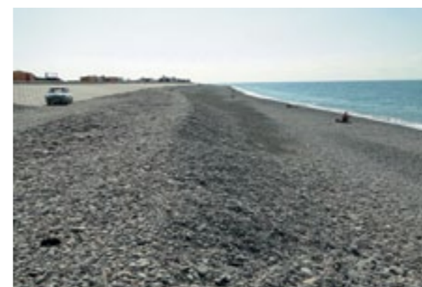
Рис. 7. Вид берегоукрепительных сооружений и пляжа между каньонами Новый и Константиновский. Сентябрь 2012 г.
