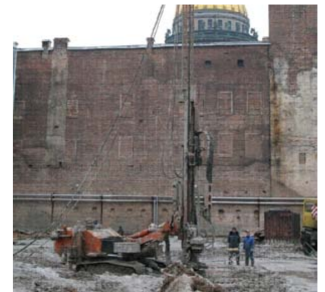
Рис. 5. Устройство закрепления грунта в уровне дна будущего котлована
