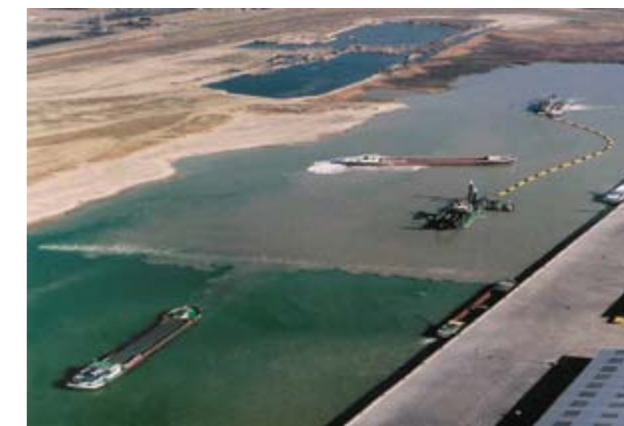
Рис. 4. Применение пузырьковой завесы в гавани Скалдия (Флиссинген)
