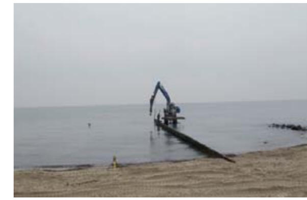
Рис. 10. Строительство бун в Померании (ФРГ), 2011 г.
