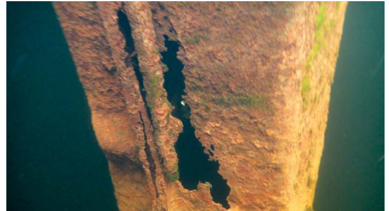
Фото 1. г. Мурманск, сквозная коррозия коробчатой сваи
