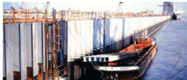
Монтаж металлоконструкции с антикоррозионной защитой Stelpant контейнерного терминала III в порту Бремерхафен
