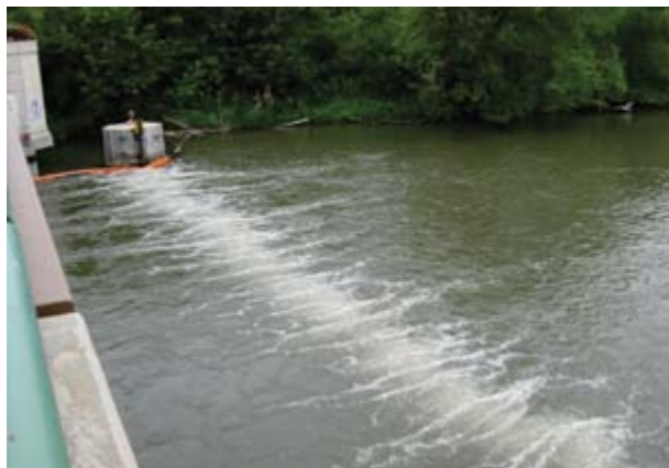
Рис. 5. Пример установки пузырьковой завесы на реке
