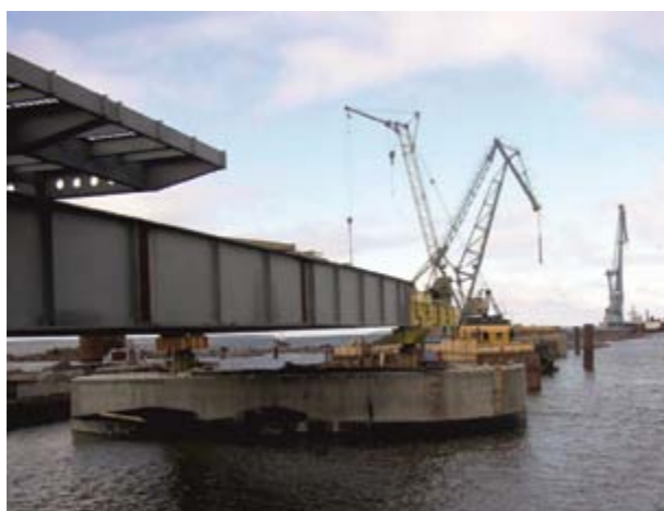
Сваи оболочки под эстакады РКПН «Лукойл-2», порт Высоцк
