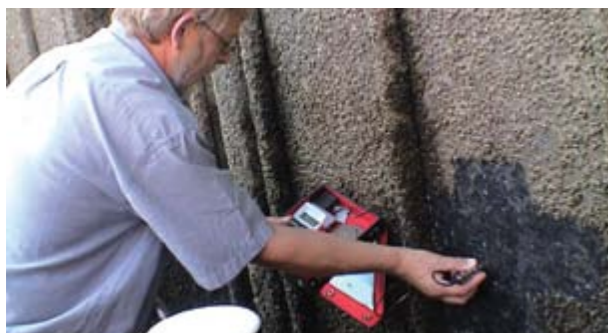
Инструментальное освидетельствование покрытия Stelpant в зоне переменного уровня в порту Куксхафен (более 20 лет эксплуатации)
