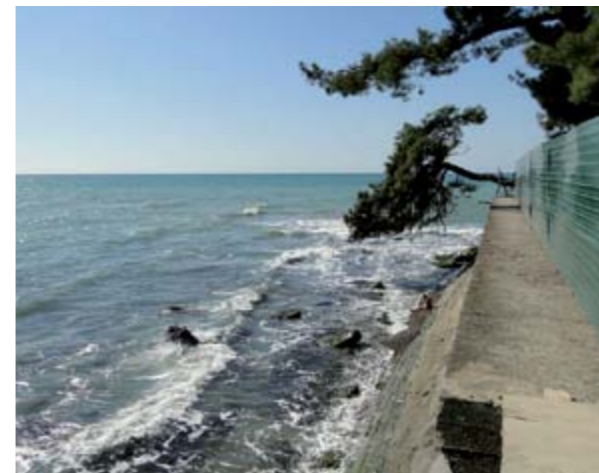
Рис. 1. Мыс Видный. Вид участка исследований до строительства
