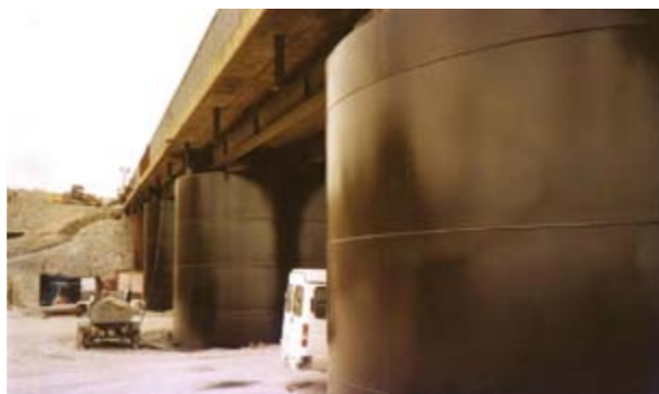
Сваи оболочки причала Гавани вспомогательных судов пос. Озеревка
