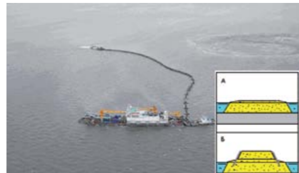
Рис. 2. Работа земснаряда на шельфе. А, В — этапы строительства МНГС
