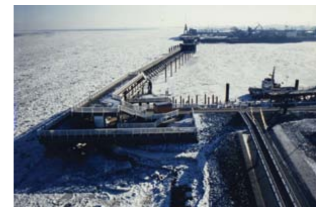
Ледовые нагрузки на металлоконструкции с антикоррозионной защитой Stelpant причалов порта Куксхафен
