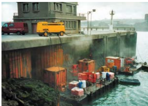
Нанесение с антикоррозионной защитой Stelpant шпунтовой стенки в условиях действующего порта Булонь во время отлива, Франция, 1998 год
