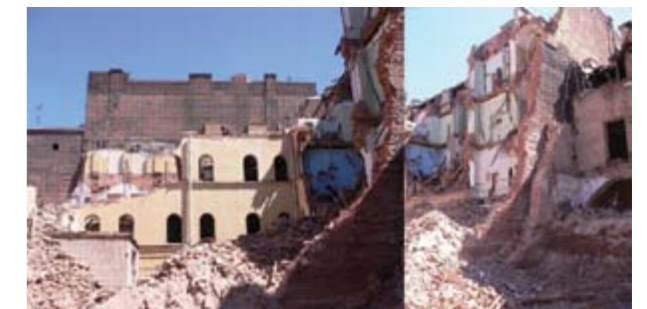
Рис. 4. Демонтаж конструкций внутридворовых флигелей
