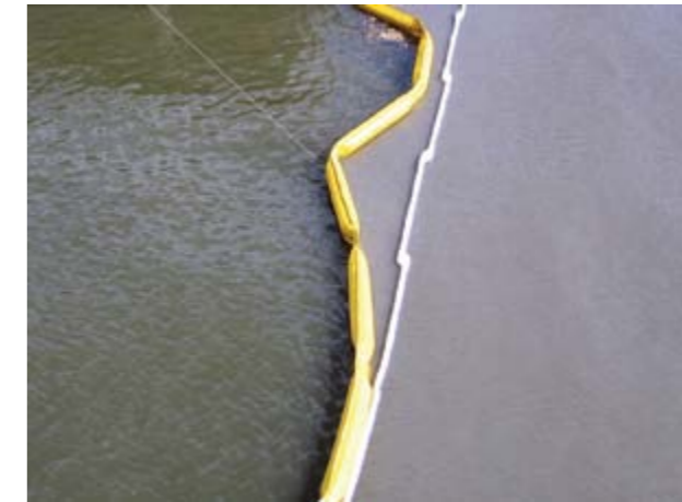
Рис. 2. Пример локализации зоны мутности с помощью илозащитного экрана
