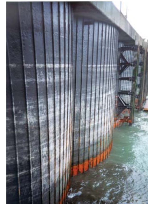
Внешний вид шпунтовой стенки в порту Булонь с покрытием Stelpant, Франция, 2010 год
