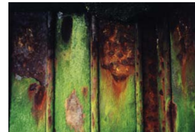
Состояние шпунтовой стенки в порту Булонь до ремонта, Франция
