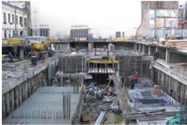
Рис. 7. Вскрытый котлован под паркинг-сейф
