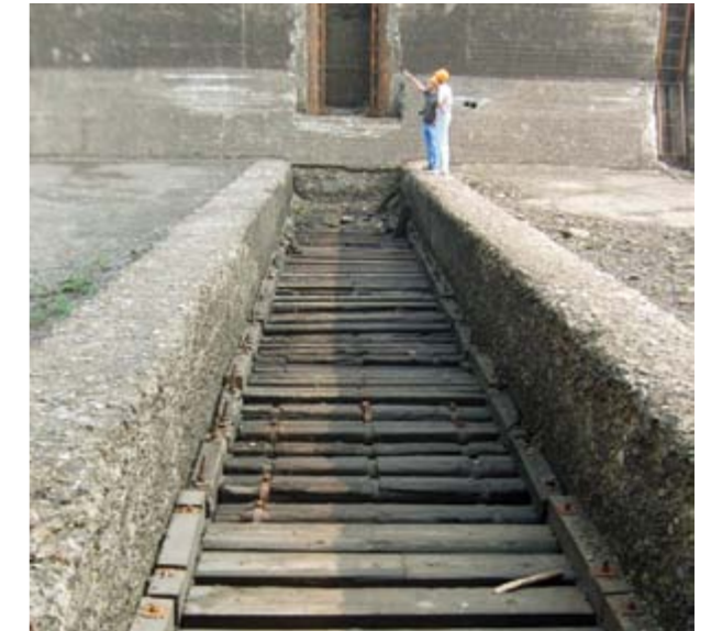
Рис. 3. Колосниковая решетка в шлюзовой камере (№ 12)
