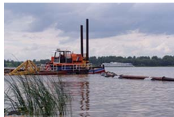
Рис. 2. Землесосный снаряд для добычи торфа (изготовитель ОАО «Завод гидромеханизации»)
