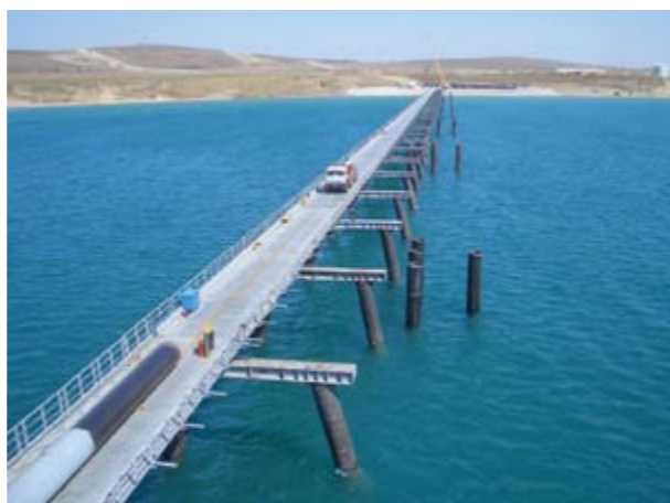
Сваи и пролетные строения причала комплекса перевалки СУГ в порту Железный Рог
