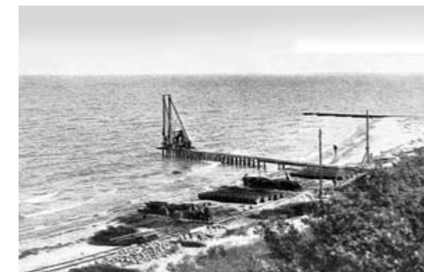
Рис. 2. Применение парового копра при строительстве бун 1897 г. [2]
