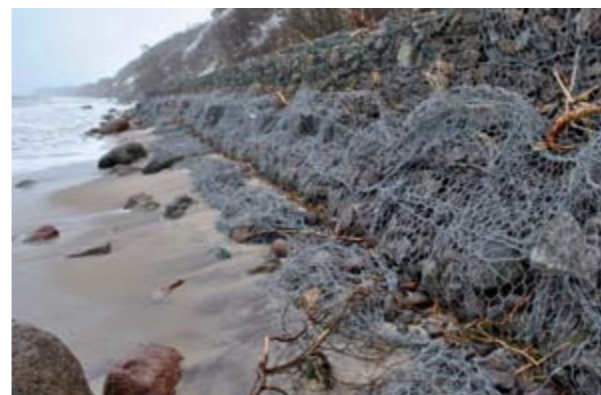
Рис. 9. Разрушение габионов у г. Светлогорска 20 января 2012 г.
