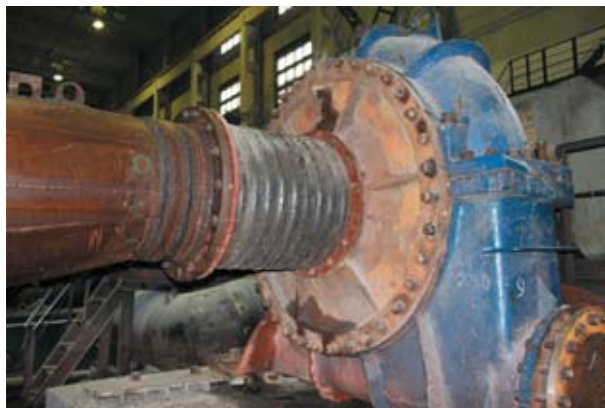
Рис. 1. Испытания напорно-всасывающего патрубка диаметром 800 мм
