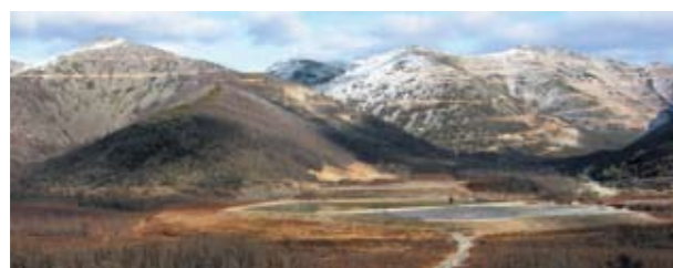
Рис. 1. Вид действовавшей III секции хвостохранилища в октябре 2009 г. (за хвостохранилищем виден карьер, из которого брался грунт для отсыпки дамбы)
