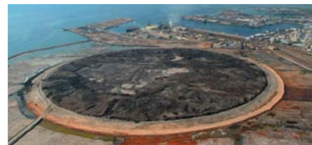
Рис. 1. Аэроснимок, сделанный в ходе проведения земляных работ (Callaert B., 2010)
