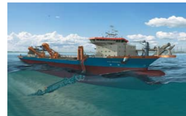
Рис. 5. Общий вид разработки подводной траншеи с помощью СТЗ
