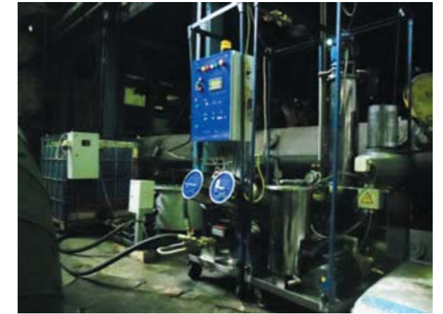
Рис. 3. Комплексы ФОДЖ, РПВП подключены к работающей турбине на энергообъектах ОАО «Иркутскэнерго»
