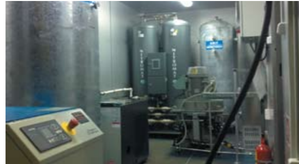
Рис. 2. МКС на базе дожимного азотного компрессора J.P.SAUER&SOHN серии TORNADO
