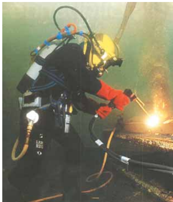
Фото 1. Водолаз-сварщик в шлеме Superlite 27 и гидрокombинезоне с водообогревом
