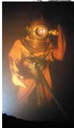
Фото 3,4. Водолазные работы в трехболтовом снаряжении
