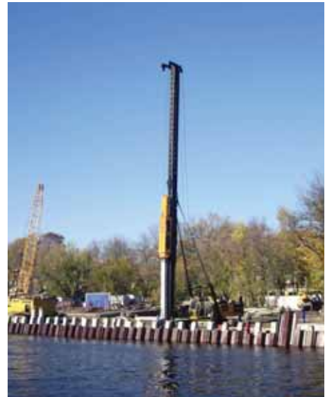
Фото 2. Шпунтовая стенка Приморской набережной в Санкт-Петербурге
