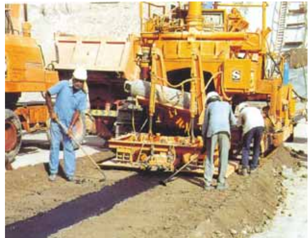
Рис. 4. Возведение диафрагмы на плотине Мускат в Омане в 1993 г. комбайном 3-го поколения
