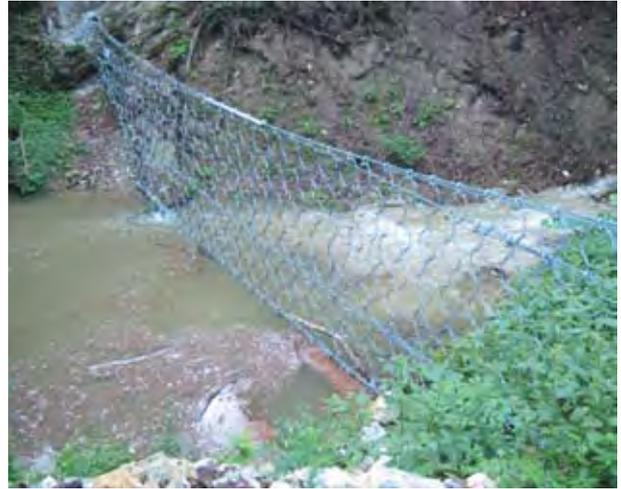
Рис. 2. Пропуск меженного расхода под селезащитным барьером
