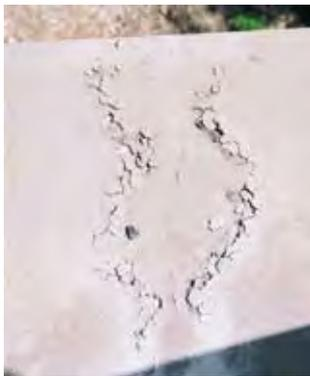
**Рис. 2.** Разрушение полимерцементных покрытий при длительном контакте с водой
