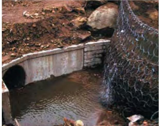
**Рис. 4.** Защита водопропускного сооружения гибкими многоуровневыми селевыми барьерами
