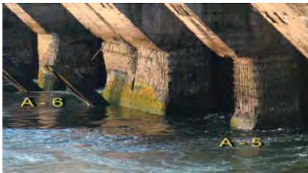
Рис. 7. Разрушение бетонных конструкций нижнего бьефа
