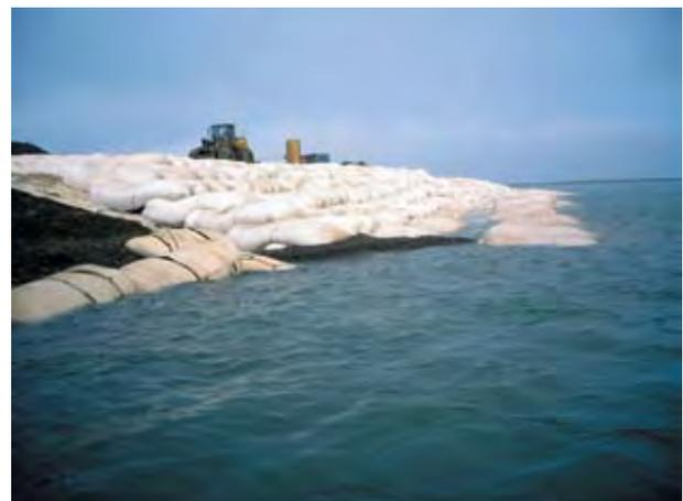
грунта в теле насыпи. Конструкция насыпей, устраиваемых на болотах II типа, включает в себя геоматрицы определенной высоты, уложенные в несколько рядов с перекрытием нижнего ряда. Откосы при этом можно устраивать с повышенной крутизной, что позволит экономить до 15% земляных работ.
