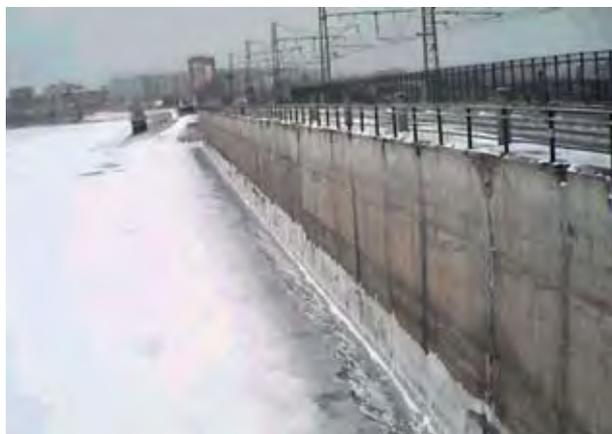
**Рис. 2.** Общий вид напорной грани русловой бетонной плотины Братского гидроузла
