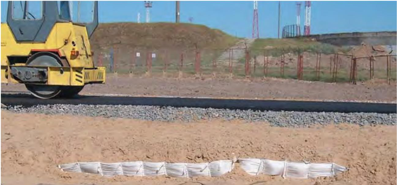
ведения земляного полотна. В районах, где имеется дефицит годных грунтов для сооружения насыпи, применение геоматрицы или геоконтейнеров позволяет использовать местные грунты с низкими физико-механическими свойствами, что дает большой экономический эффект, сокращает стоимость строительства.
