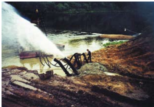
Рис. 8. Разработка подводной траншеи через р. Днепр в р-не Орши в условиях скального грунта VI гр. (доломит). 1997 г.
