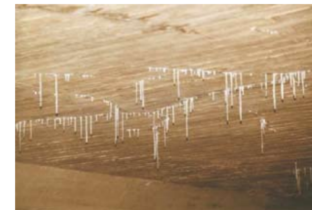
Рис. 2. Трещины на нижней стороне перекрытия
