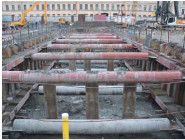
Рис. 2. Опытная площадка на строительстве Мариинского театра-2 в Петербурге (2008 г.). Общий вид котлована. Эскавация выполнена до проектной отметки
