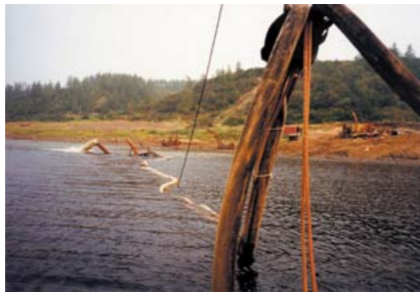
Рис. 9. Подача рабочей воды на «гидронож» осуществлялась от двух дизельнасосных установок ГМ-360 по двум рукавам диаметром 150 мм. 2002 г. р. Енисей
