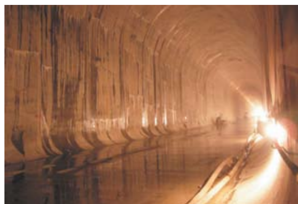
Рис. 5. Береговой водосброс СШГЭС
