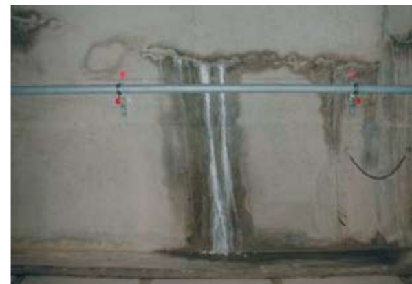
Рис. 1. Холодные швы в бетонных конструкциях
