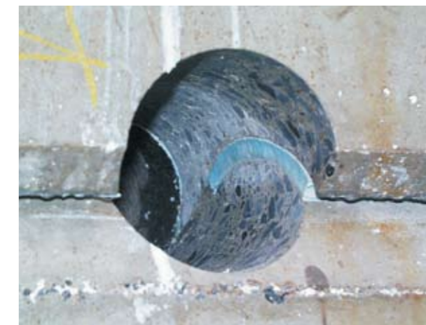
Рис. 8. Заполнение швов гидроструктурной смолой MC-Injekt GL 95TX
