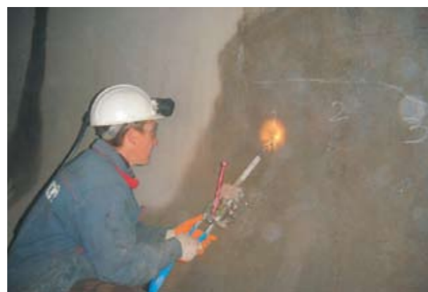
Рис. 6. Производство работ по инжектированию на СШГЭС
