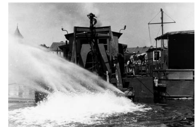
Рис. 3. Первый «гидронеж», как и скрепер-пульпомет, смывал грунтовую стружку за пределы траншеи
