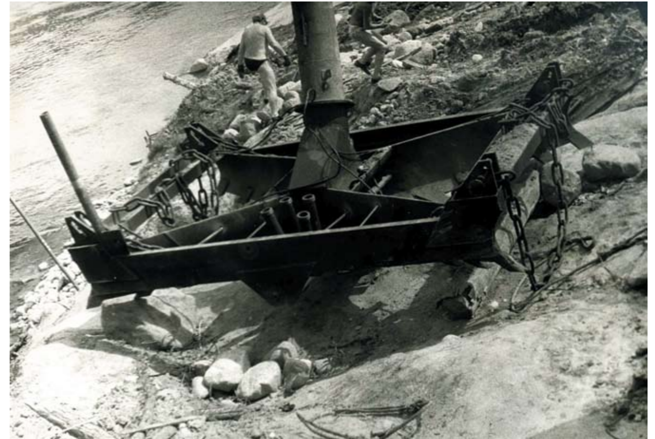
Рис. 7. «Гидронож» конструкции Лифа преодолел недостатки предшественников, но приобрел собственные
