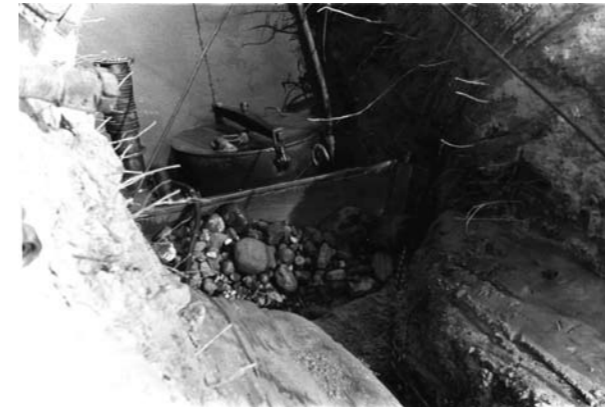
Рис. 1. Рабочий орган скрепера-пульпомета конструкции «Гипроречтранс» в прирезной части подводной траншеи. Снаряд оказался бессилен в гравийно-галечниковых грунтах
