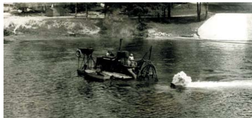
Рис. 6. Подача рабочей воды к «гидроножу» осуществлялась от дизель-насосной установки ГМ-360
