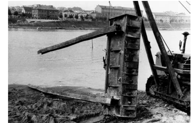
Рис. 2. Первый «гидронеж», сделанный из бульдозерного ножа-отвала. Река Неман, Каунас, 1964 г.
