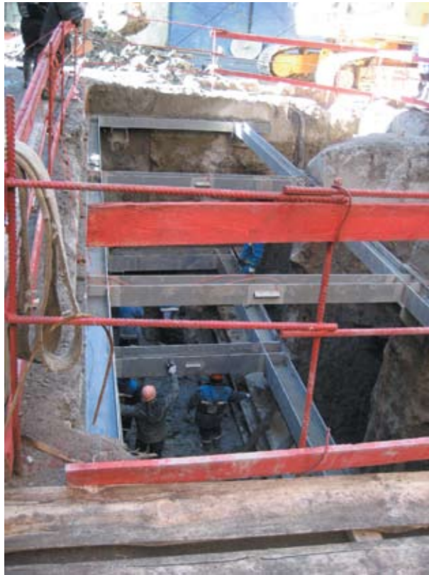
Рис. 5. Вид опытной площадки после откопки котлована (Санкт-Петербург, Зоологический пер., 2–4)
