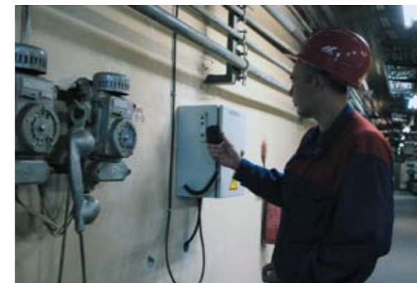
УКВ радиостанция на гребне плотины в помещении гидроподъемников, у каждого есть своя
