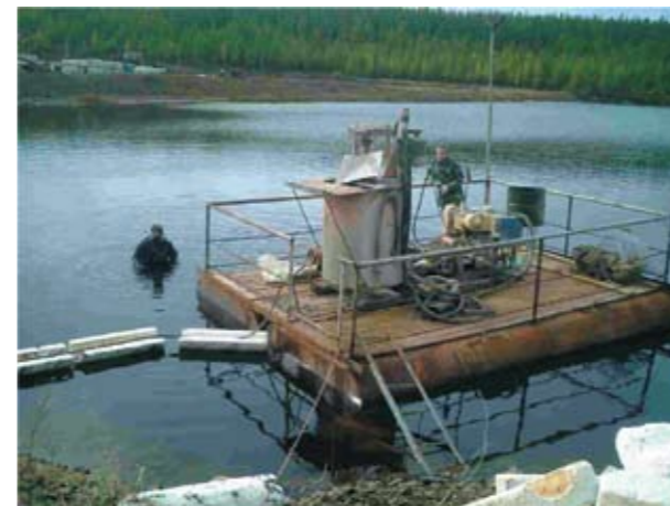
Фото 3. Понтон с оборудованием для приготовления и закачки криогелей в каверны на дне Иреляхского водохранилища
