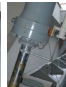
Рис. 3. Гидроцилиндр для подъема сегментного затвора
