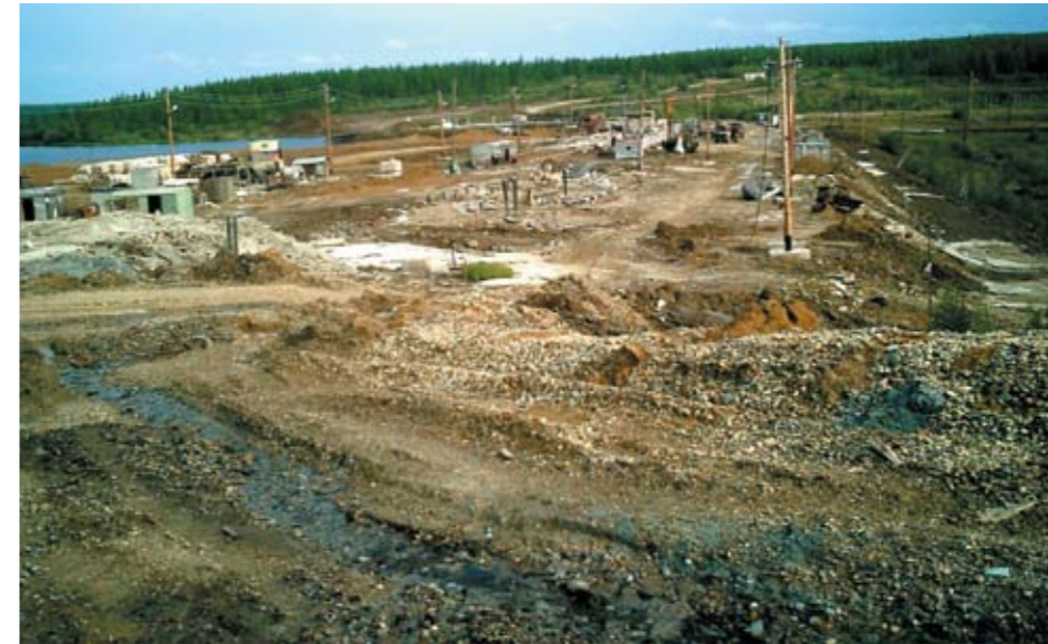
Фото 1. Вид с правого берега по оси Иреляхской плотины
