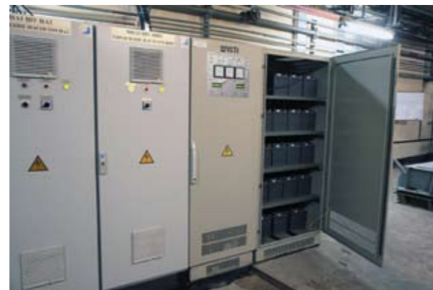
Аккумуляторы для резервного питания маслососов и гидроподъемников
