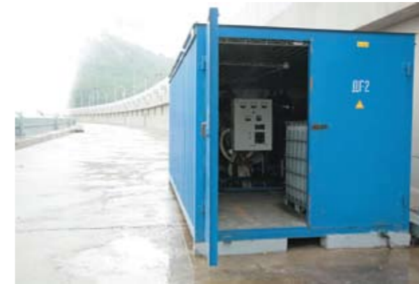
Дизель-генератор для резервного питания гидроподъемников затворов
