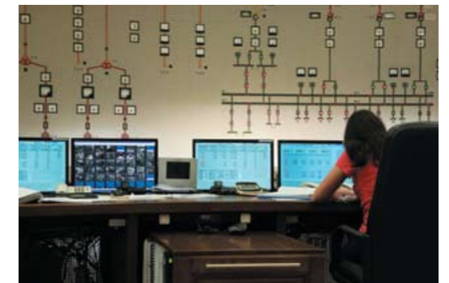
УКВ радиостанция на ЦПУ внизу под столом и система видеонаблюдения (монитор слева)
