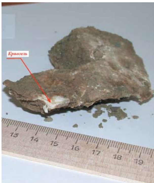
Фото 7. Заполненные криогелем каверны в керне, отобранном при бурении контрольных скважин на правобережном примыкании
