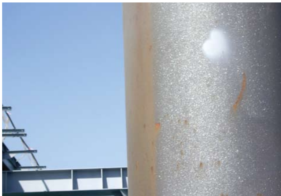
Рис. 5. Коррозия в зоне брызг
