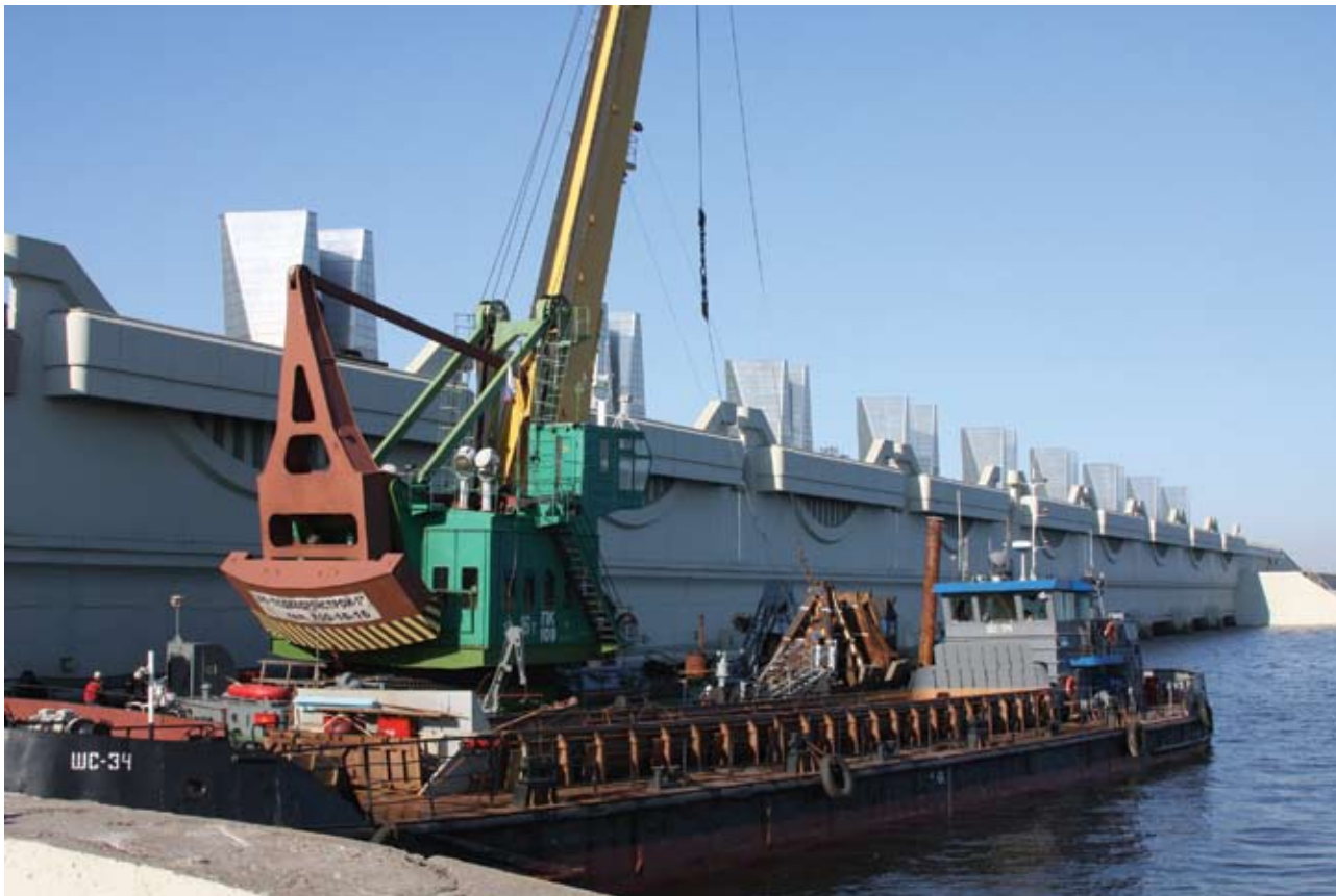
Очистка порогов водопропускных сооружений Комплекса защитных сооружений Санкт-Петербурга от наводнений
