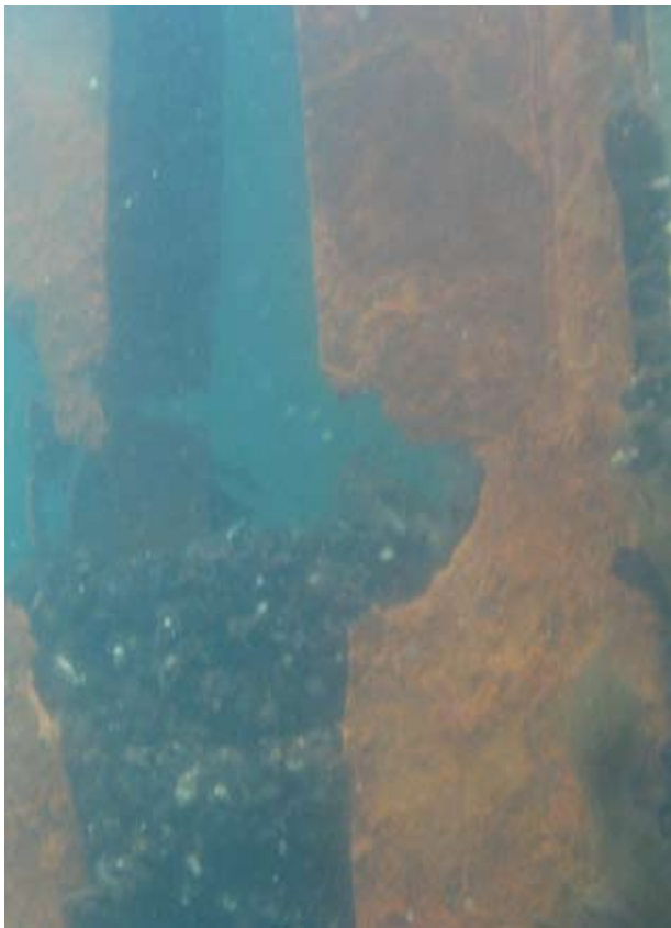
Рис. 3. Коррозионные повреждения морских сооружений
