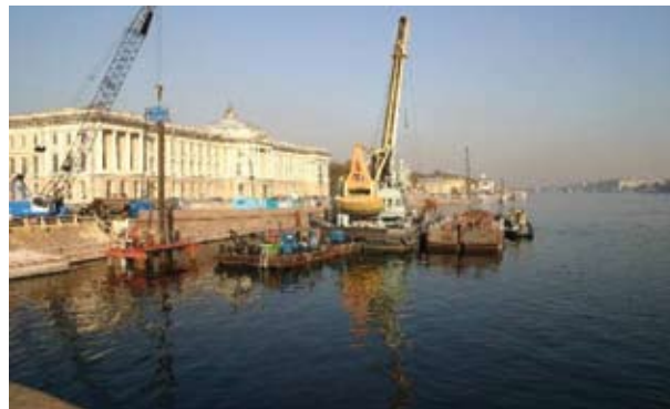
Строительство моста-дублера во время реконструкции моста Лейтенанта Шмидта
