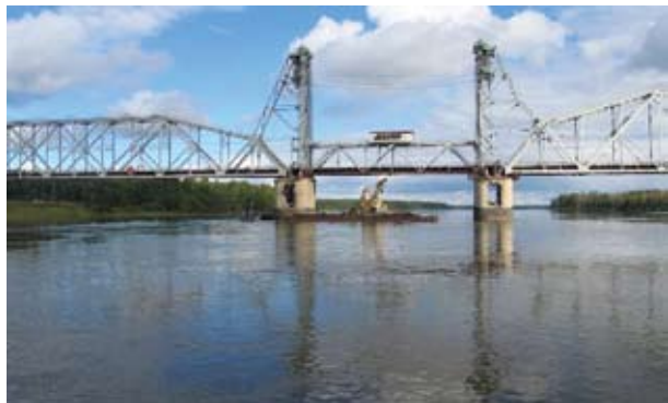
Прокладка оптико-волоконной линии связи в районе Кузьминского моста
