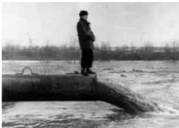
На золоотвале Прибалтийской ГРЭС
