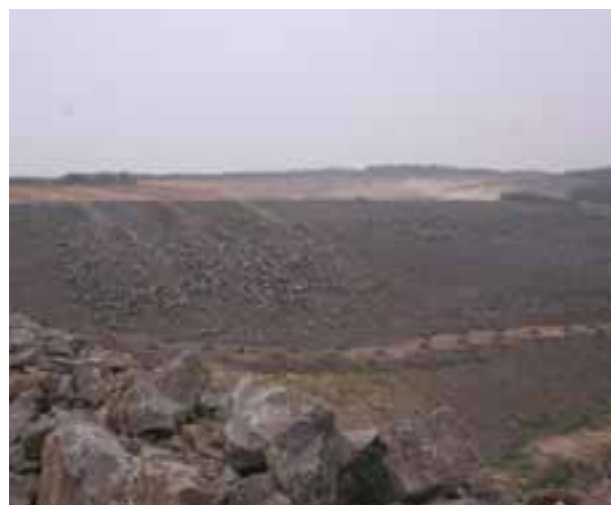
Рис. 5. Строительство рыбозащитного приплотинного рифа
