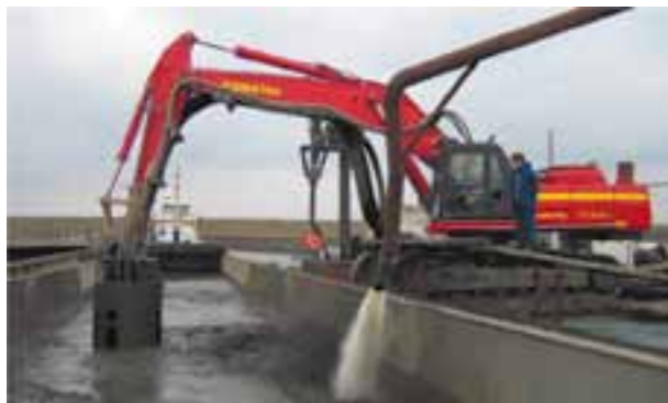
Рис. 3. Выгрузка загрязненного грунта из трюма баржи на «Айзелохе»
