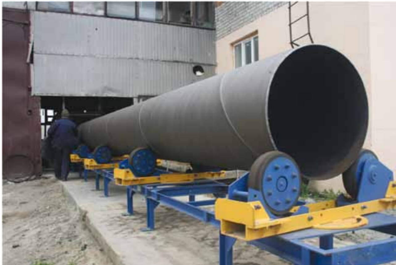
Рис. 1. Стенд подачи труб для очистки в дробеструйной установке
