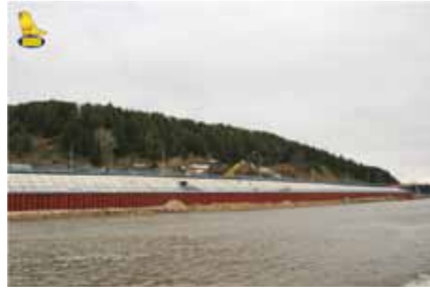
Рис. 5. Укрепление берега р. Иртыш и подхода к мосту в г. Ханты-Мансийске
