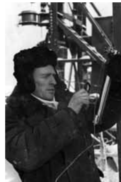
На строительстве Молотовской (Ниже-Камской) ГЭС
