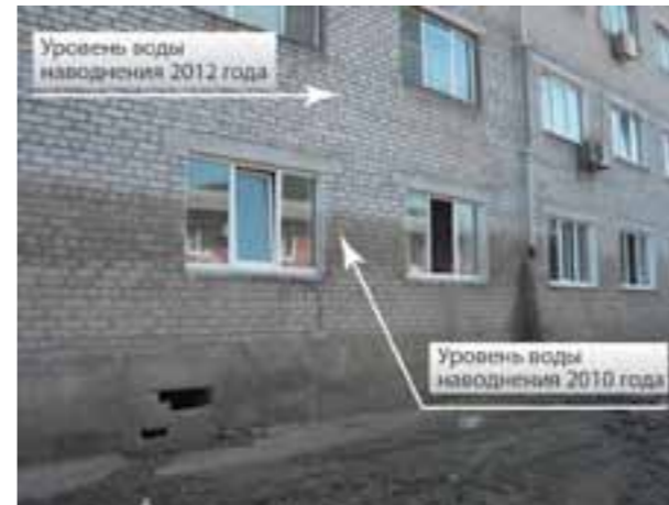
Рис. 6. Уровень воды во время наводнения в июле 2012 г. достигал 2 этажа (пос. Новомихайловский, Туапсинский район)
