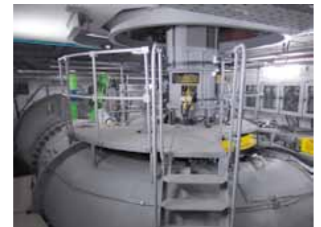
Рис. 7. Турбина гидравлическая после реконструкции, 2012 г.
