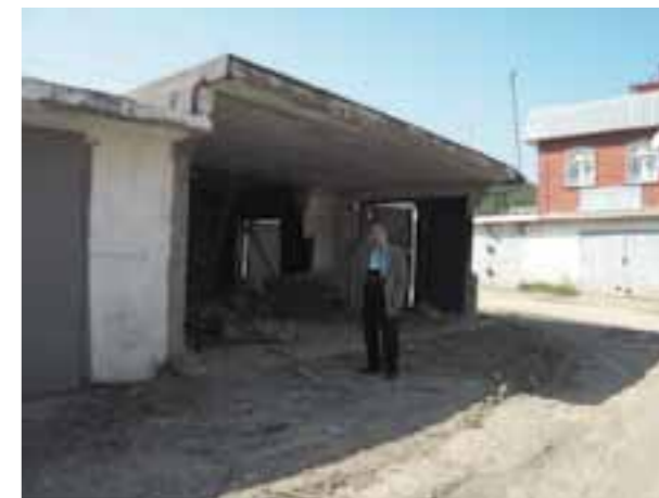
Рис. 7. Г. Л. Кофф у гаража, разрушенного водами реки Нечипсухо
