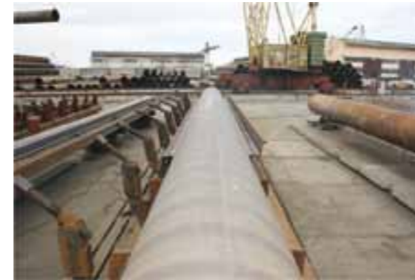
Рис. 2. Стенд для сборки ШТС «Трест Запсибгидрострой» на основе труб демонтированного нефтепровода
