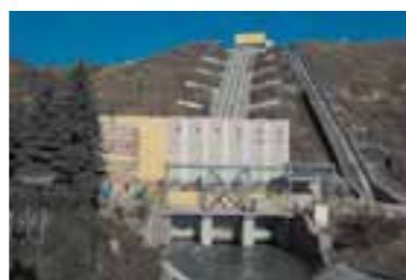
Рис. 12. Здание ГЭС после реконструкции, 2012 г.
