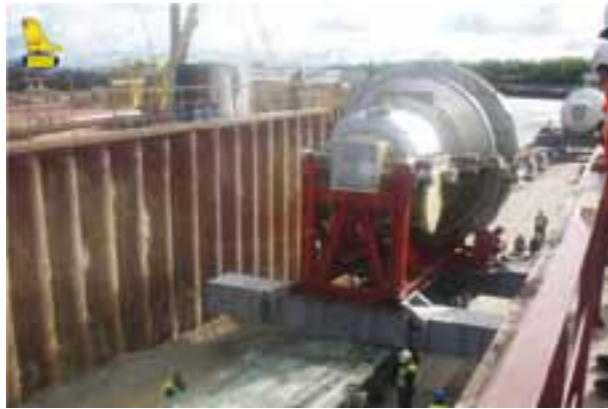
Рис. 4. Причал для крупногабаритного и тяжеловесного оборудования из ШТС «Трест Запсибгидрострой» в п. г. т. Приобье
